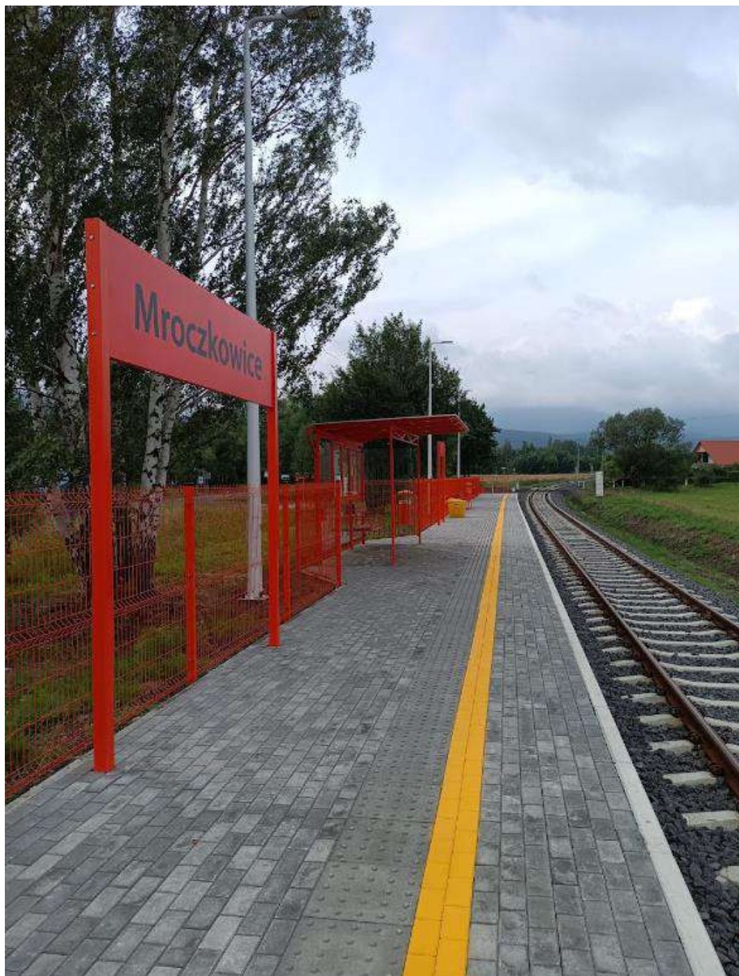
Figura 3-30 - Stația Mroczkowice (Sursa: Google Earth)
